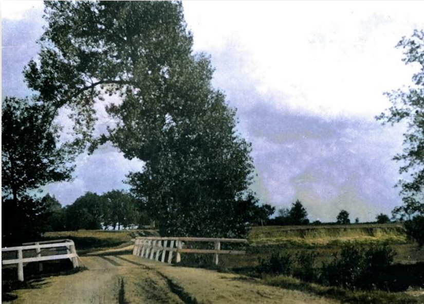
Goormatenweg met de Dinkelbrug.
