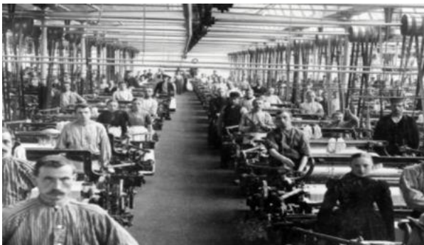
Fabriekscomplex ten Cate in Nijverdal. Goed te zien is hoe de weefgetouwen via poelies en aandrijfrie- men werden aangedreven. Die poelies werden via lange aandrijfassen door een centrale stoomma- chine aangedreven.
