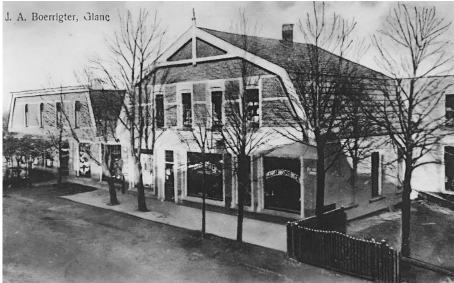
J.A. Boerrigter in Glane. Destijds tegenover het voormalige station.
